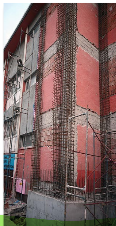
Un bâtiment scolaire à Istanbul en cours de réhabilitation par l'ISMEP
