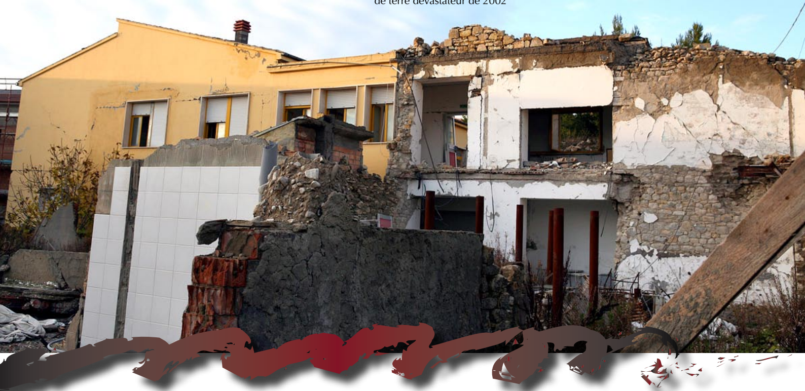
Les restes d'une école primaire à San Giuliano après le tremblement de terre dévastateur de 2002
